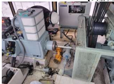
主電動機の整備
